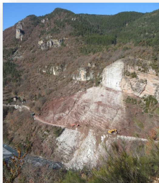
Deux éboulements majeurs sur le RD 2202 en 1997 (à gauche) et en 2012 (à droite)
