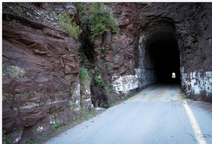
Entrée d'un tunnel sur la RD 2202
